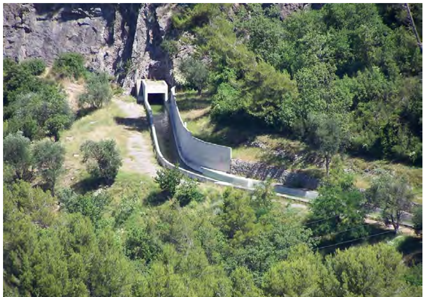
Il canal de la Vésubie, in comune di Roquette-sur-Var. Costruito tra 1879 e 1885, fu prolungato nel 1894 fino a Mentone (foto Eric Coffinet, 2007, fr-wikipédia)
